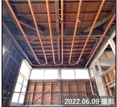
図1 土浦亀城邸の解体調査
